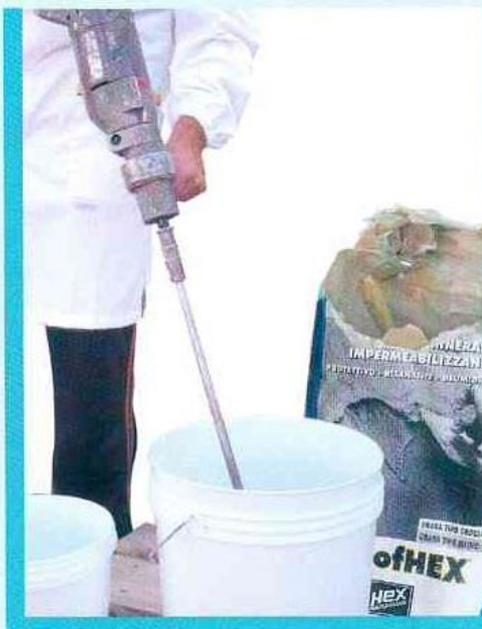
**3** Miscelare il tutto con trapano munito di apposita elica o betoniera per circa 3/5 minuti.
